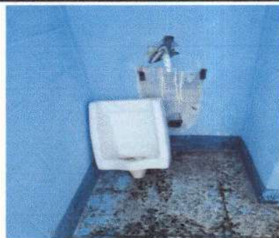
Foto 4: Colocación de mingitorio
