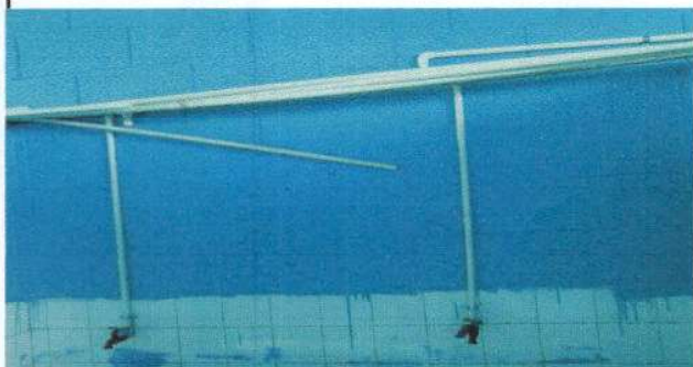
Foto 5: Instalación de tubería en los baños
