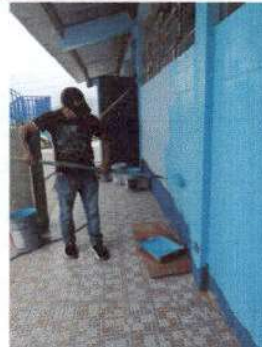
Foto 2: Pintura en muros exteriores e interiores
